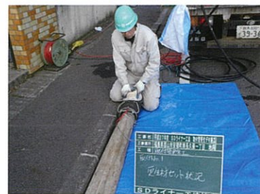
取付管更生材装着状況
