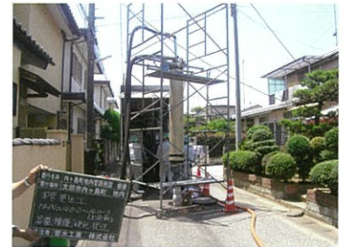
更生材硬化状況
