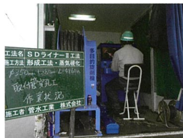
穿孔ロボット操作状況
