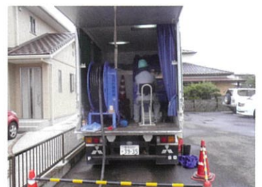
穿孔ロボット操作状況
