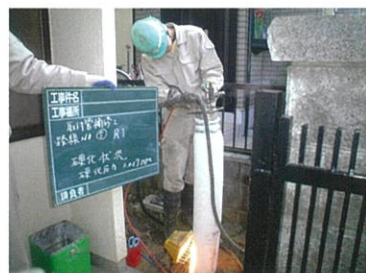
取付管更生材硬化状況
