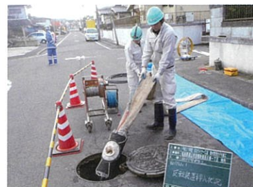
取付管反転装置引込状況
