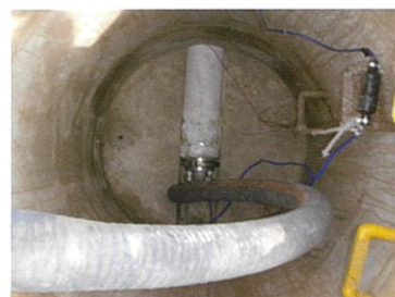
拡張・硬化状況
