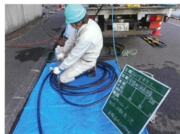
反転装置エア注入状況
