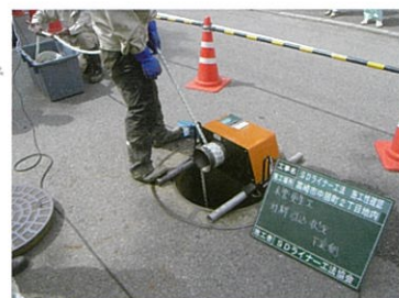
電動ウインチ巻上げ状況
