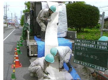
材料挿入状況
