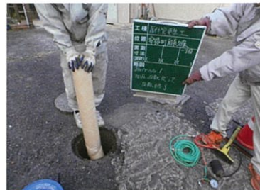
取付管更生材反転状況
